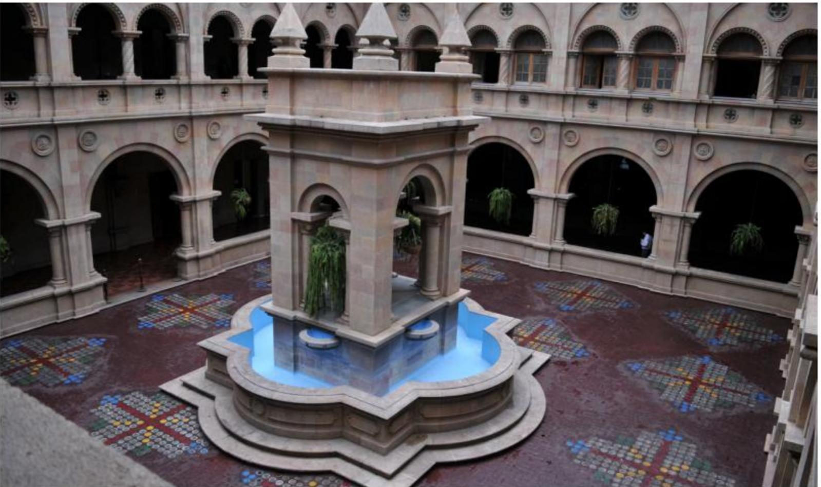
En el primer y segundo nivel, se observa en los corredores que rodean el patio central, la utilización de arcos de medio punto con columnas de fuste liso y torneado, capiteles trabajados con distintos diseños, en los zócalos de los muros se ha utilizado cuatrifolio (elementos ornamentales compuestos por cuatro lóbulos).
