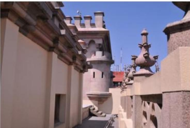
El contraste de la piedra tallada de los arcos y columnas con el resto del muro que tiene repello más alisado con acabado final de pintura. Detalle de ventanas ubicadas en el cuarto nivel en el ducto de gradas secundarias, se utilizó la madera para el marco y vidrio transparente cuadriculado.
