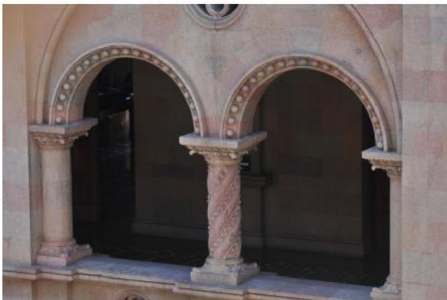
A diferencia del primer nivel, aquí se utilizó el arco escarzano en el área del torreón No. 2, observándose la continuidad de los arcos de medio punto para los accesos de las gradas secundarias, al centro se encuentra la puerta de acceso para el ascensor.
