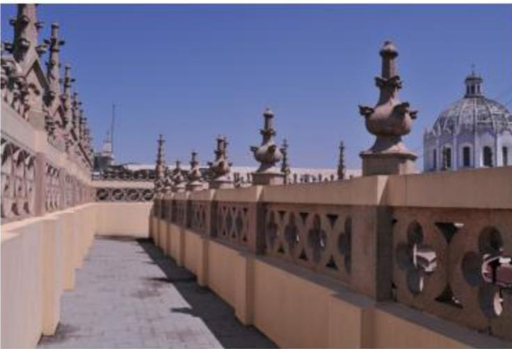
Se observa la pared que circula la terraza del tercer nivel, de piedra martelinada, con elementos decorativos. A la derecha sobresale el muro que permite la doble altura al salón de actos.
